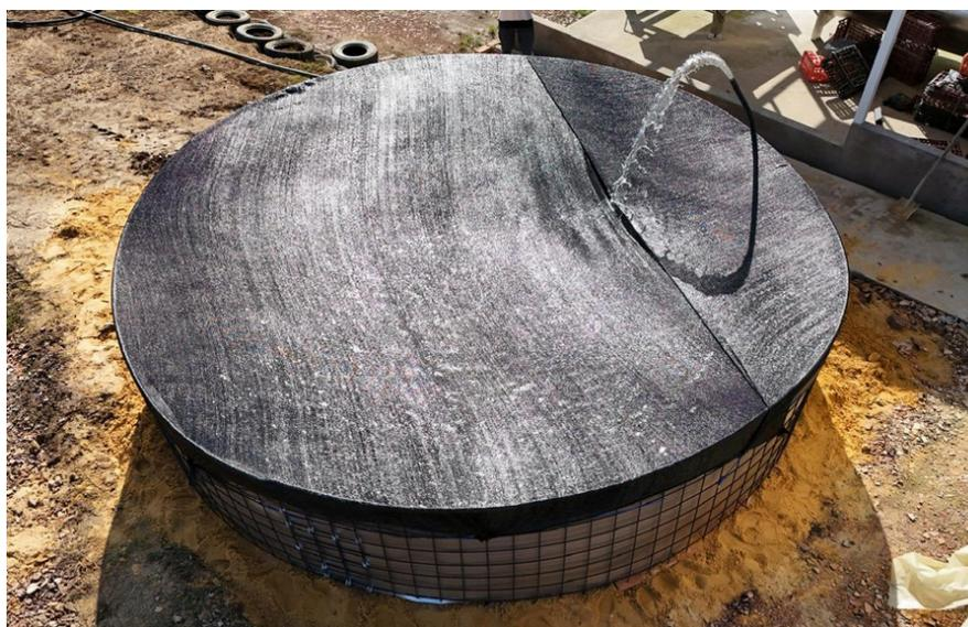
La geomembrana no solo evita que el agua se filtre y se disperse, sino que también se concentre en un solo sitio. Se coloca dentro del tanque formado con malla electro soldada (6 a 8.5 mm) para darle forma a la estructura, asegurado don pernos de alta resistencia y puede instalar sobre cualquier base (tierra, concreto, madera)
